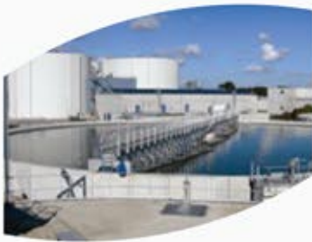
Effluent Treatment Plant (ETP)
